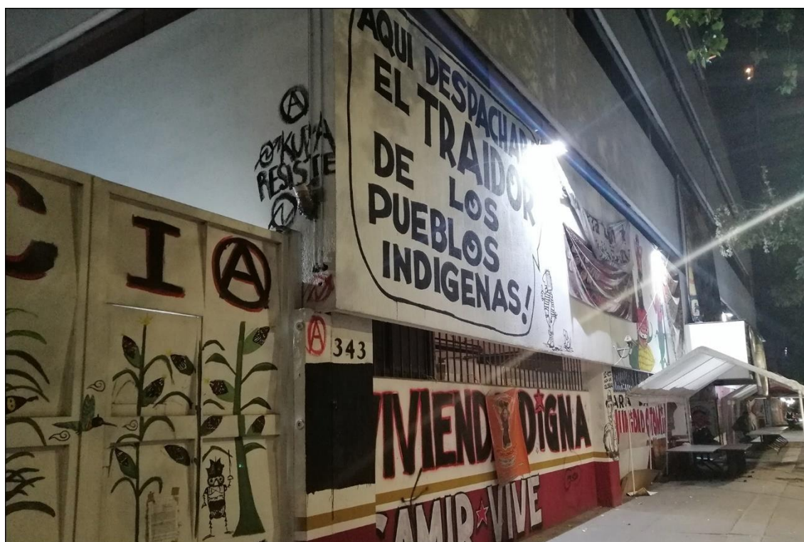
Figura 7. Grafitis en la fachada del edificio tomado
