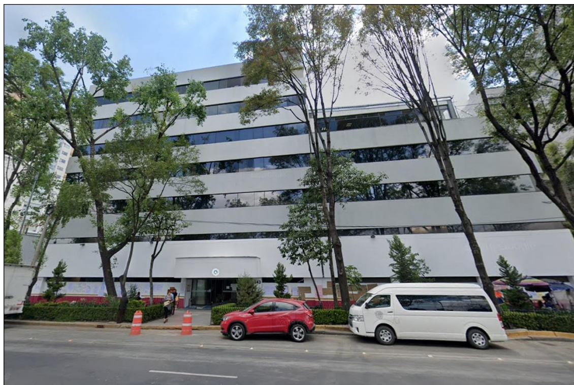
Figura 25. Fachada original del edificio del INPI
