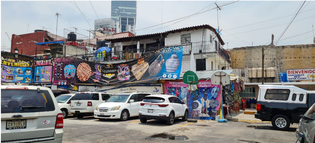
Imagen 6. Edificio residencial de la comunidad triqui
