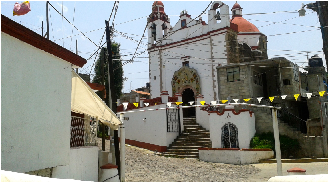
Figura 20. Capilla del puente. Fotografía propia.
