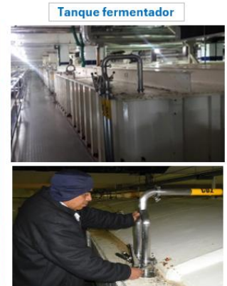
Operador haciendo la conexión de tanque
