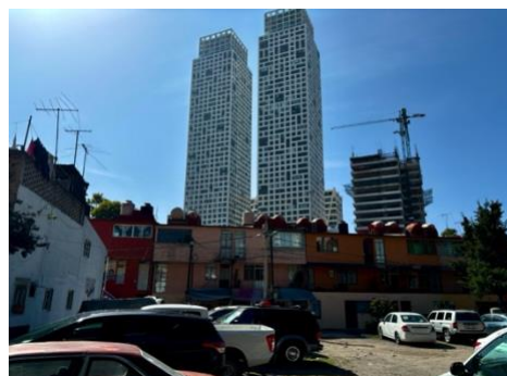
Imagen 6. Tomada desde el andador 12 de la cooperativa. Edificios residenciales construidos por Del Parque y Gigante Grupo Inmobiliario (en construcción) (Imagen de archivo personal, 2024)
