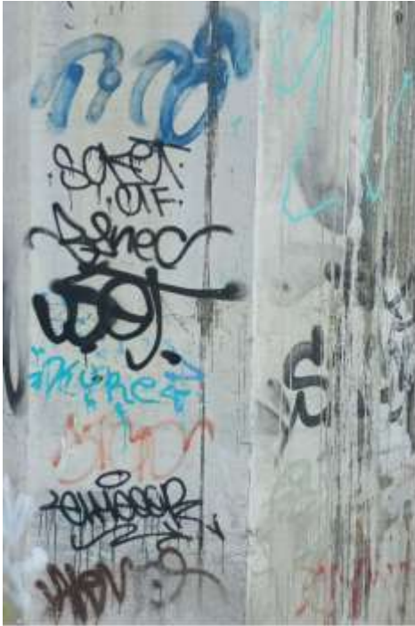
Estilo: Tags Técnica: aerosol Basnueva, G. M. (2023). Diario de campo en Santa Fe. Fotografía del autor.
