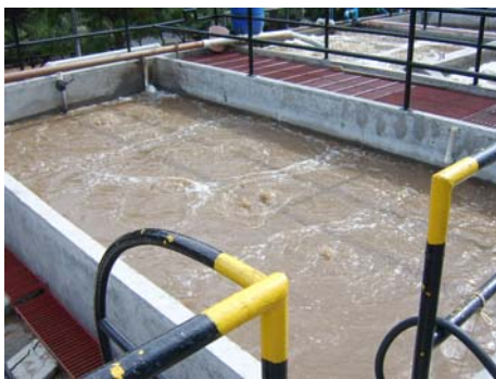
a) Extracción del lodo.
