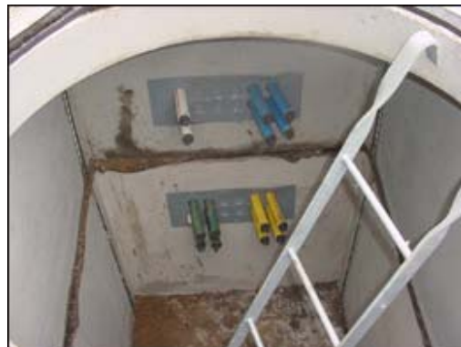
Colocación de registros eléctricos de Concreto Polimérico 2
