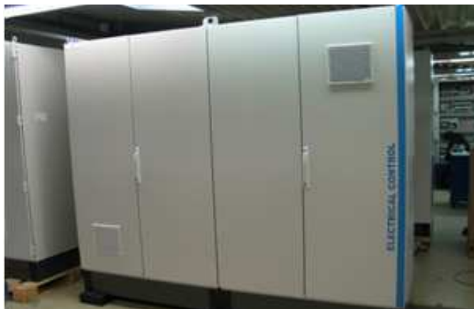
Figura 2.6.8.b) Tablero de entradas y salidas.
