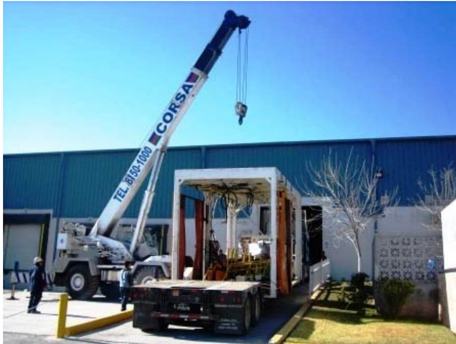
Figura 5.5 Descarga de maquinaria tapetes en planta Ramos Arizpe.
