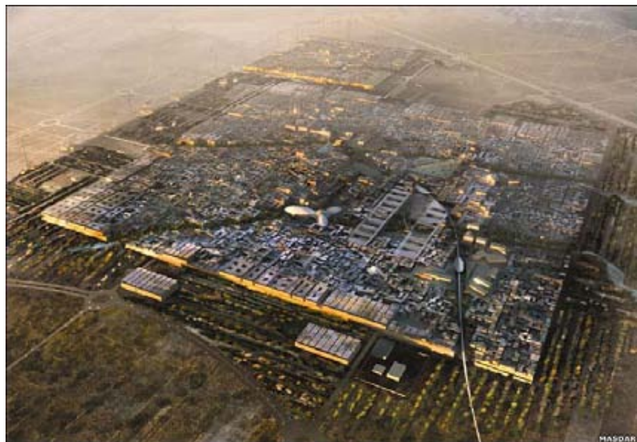
Masdar, Abu Dhabi. En construcción
