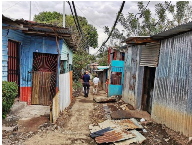
Fotografía #8: Estructuras de las viviendas, junio del 2022.
