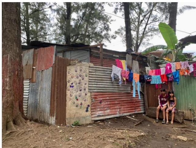
Fotografía #7: Estructuras de las viviendas, junio del 2022.
