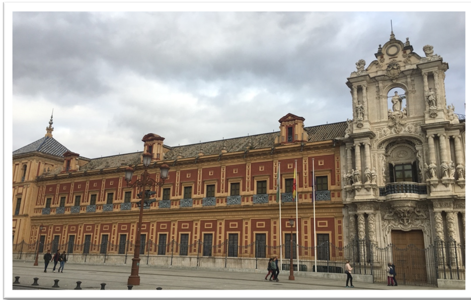
Figura 29 Palacio de San Telmo, Sevilla, España. En la fachada se aprecia el paramento avitolado. Fotografía: María Sánchez Vega, 10 de noviembre de 2018
