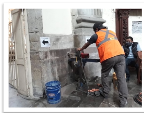
Figura 33. Extracción de corazones en la parte baja del muro de la Iglesia de Nuestra Señora de Loreto en la Ciudad de México Fotografía: Salvador Ávila Gaytán, mayo 2021
