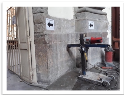
Figura 32. Maquinaria utilizada para la extracción de corazones en la parte baja del muro de la Iglesia Nuestra Señora de Loreto en la Ciudad de México Fotografía: Salvador Ávila Gaytán, mayo 2021.
