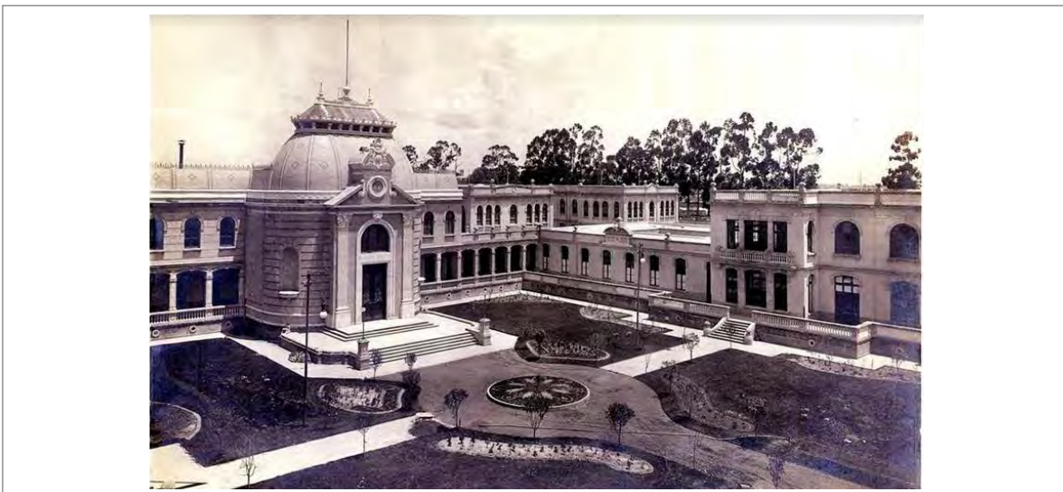
Un palacio para los menesterosos. El Hospicio de Pobres, proyecto de los ingenieros Roberto Gayol y Mateo Plowes. Su construcción inició en 1900 y se inauguró en 1905. Para cuando cayó el Porfiriato, en 1911, llevaba 6 años en operación. Tenía capacidad para mil beneficiarios, 600 niñas y 400 niños. Pervivió, con la misma función de hospicio para huérfanos e internos pobres, hasta fines de los años 60 del siglo XX, cuando fue demolido. Arriba: Plano del proyecto. En medio: El imponente patio central. Abajo: vista de la plaza de acceso al inmueble.
