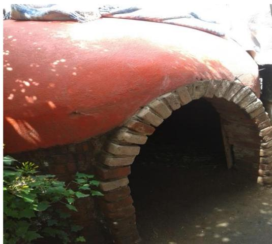
Figura 2.3: Exterior del temazcal donde se puede apreciar su construcción abovedada
