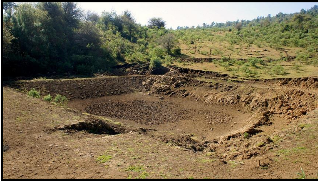
Imagen 15: Construcción de hoya de captación de agua pluvial en el paraje de Pozaro. Trabajo de campo, 2014.
