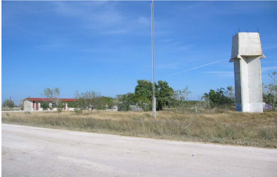
Fotografía 1. Vista de la Escuela Primaria y el tanque elevado de agua potable.
