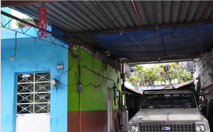
Imagen13. Entrada de casa con patio dividido.
