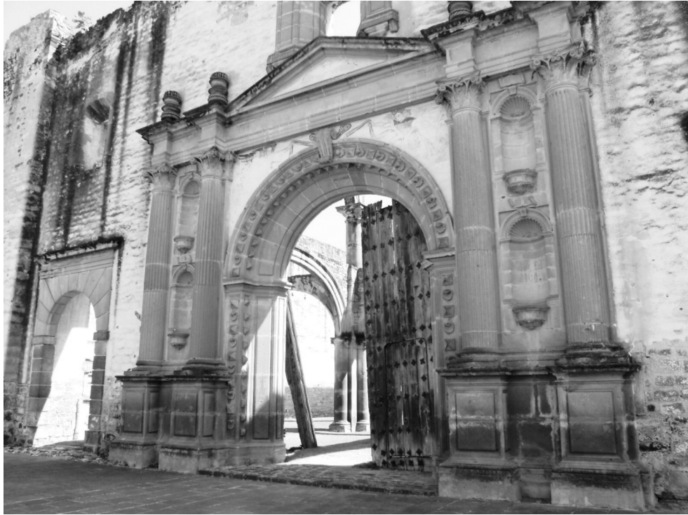
Fig. 10. Iglesia franciscana de Santiago: fachada. Tecali (Puebla, México).
