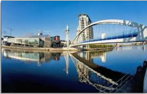
FIGURA 09. MILLENIUM BRIDGE, MANCHESTER UK. 24
