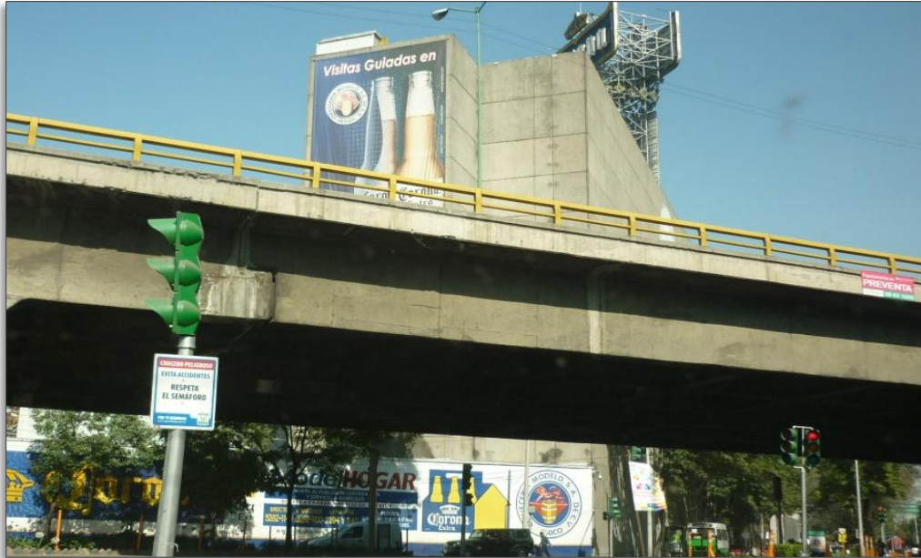
IMAGEN: ARQ. PILAR ÁLVAREZ. 2011.
