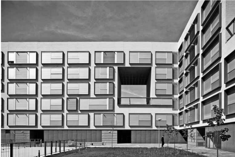
Edificio de vivienda en Fuenlabrada. Madrid, España. Foto: cortesía del despacho de CEA, 2008.
