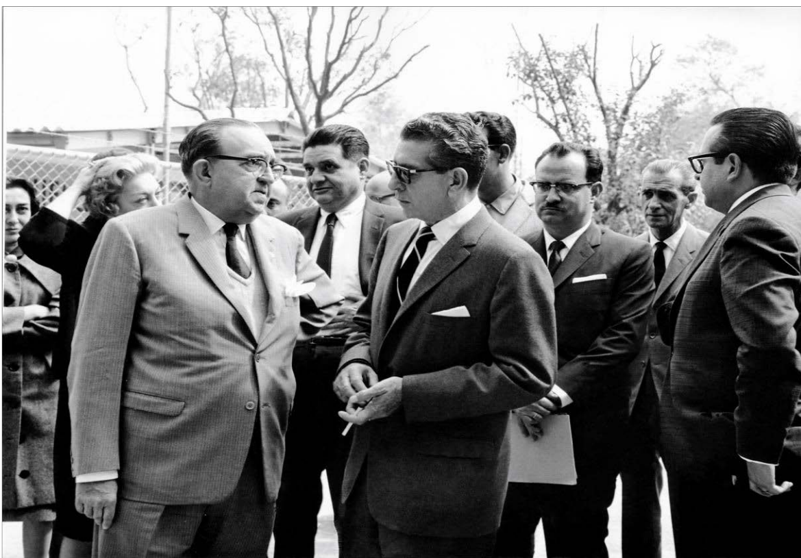
Adolfo López Mateos de visita a la construcción. Lo acompaña Alfonso Caso, Amalia Caballero, Ernesto p. Uruchurtu, Eusebio Dávalos Hurtado y Pedro Ramírez Vázquez (febrero 1963). Archivo Pedro Ramírez Vázquez.
