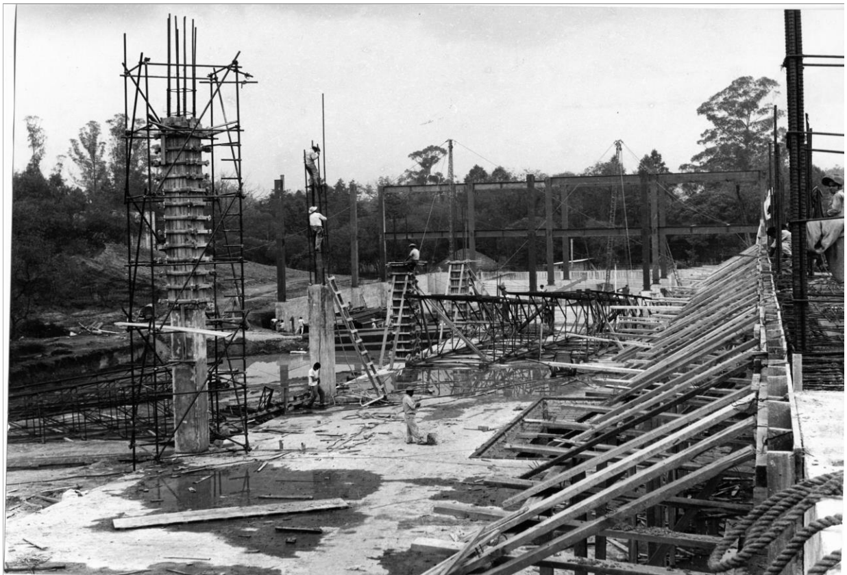
Entrada, patio central y columna del Paraguas en los inicios de la construcción (julio 1963). Archivo Pedro Ramírez
