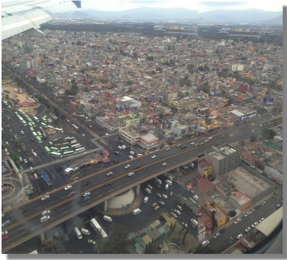
Fotografía No. 9 Vista área de la estación de transferencia modal metro Puerto Aéreo, Boulevard Puerto Aéreo esq. Av. Zaragoza, Delegación Venustiano Carranza, México, D.F. 184
